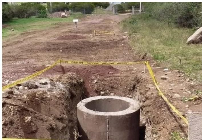
Son estructuras cilíndricas o troncocónicas (sólo en casos especiales serán cuadrados) con paredes hormigón, con tapas circulares de hierro fundido y escalerillas de ascenso, a 0.40 m.
